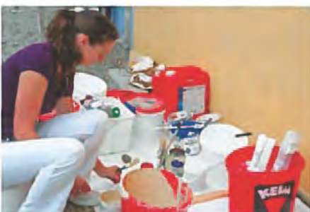
Nicht von der Stange: bis auf die Fassadengrundfarbe wurden alle Farbtöne von Hand gemischt.
