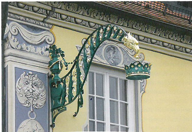
Nicht nur der historische Krone-Ausleger wurde rekonstruiert, auch die prächtigen Fassadenmalereien wurden neu gemalt.
