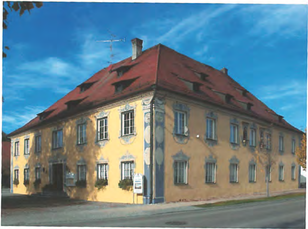
Nicht von der Stange: Bis auf die Fassadengrundfarbe wurden alle Farbtöne von Hand gemischt.
